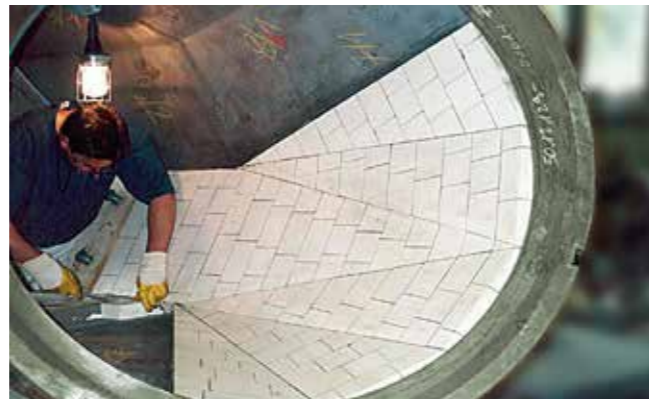
Trémie octogonale équipée d'un revêtement KALOCER; afin de réaliser une adaptation optimale, la coupe des pièces de forme de 50 mm d'épaisseur est tridimensionnelle.
