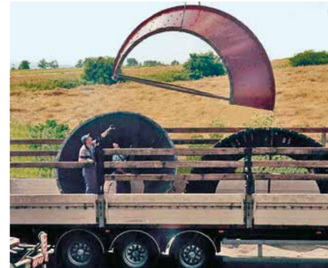
Cônes de cyclones en KALMETALL W 100 6 + 4, préfabriqués pour un montage simple.
