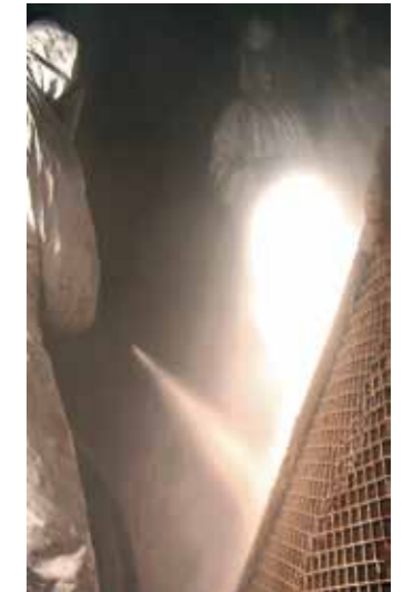
Mise en p/ace rapide de la protection d'un cyclone grâce à l'utilisation combinée du composite dur KALCRET BTS et du corindon de zirconium KALCOR. Le temps de mise en oeuvre du KALCRET BTS peut atteindre 5 m 2 /h.
