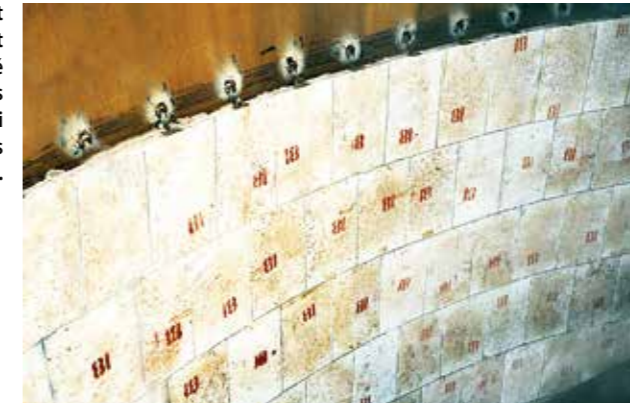
Mise en p/ace rapide de la protection d'un cyclone grâce à l'utilisation combinée du composite dur KALCRET BTS et du corindon de zirconium KALCOR. Le temps de mise en oeuvre du KALCRET BTS peut atteindre 5 m 2 /h.
