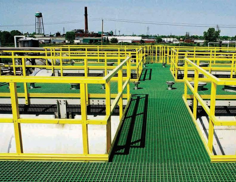
Le Plastique Renforcé par des Fibres de Verre (PRF) est un matériau composite fait d'une matrice polymère renforcée par des fibres, normalement des fibres de verre. Le polymère fournit une excellente résistance chimique et les fibres fournissent l'intégrité structurelle. Selon le type de résine et le rapport verre-résine, les propriétés du matériau pour une couche structurelle unique peuvent être optimisées en termes de résistance à la corrosion et force physique.
