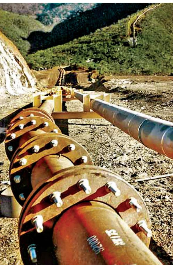
Les tuyaux, coudes ou accessoires de tuyauterie sont recouverts de matériaux pour les rendre résistants à l'usure. Les systèmes de tuyauterie hydrauliques et pneumatiques doivent souvent supporter des conditions extrêmement difficiles. Acheminer des matériaux abrasifs tel que cendre, sable ou poussière d'aggloméré soumet les pipelines à de hauts niveaux de stress. La protection contre l'usure correcte assure la continuité du processus de production.
