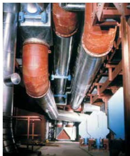
Les tuyauteries de transport de poussières de charbon sont une application typique dans les centrales électriques.
