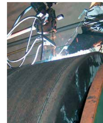
Le service Kalenborn résout les problèmes d'usure
