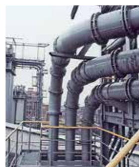
Les tuyauteries de transport de poussières de charbon sont une application typique dans les centrales électriques.
