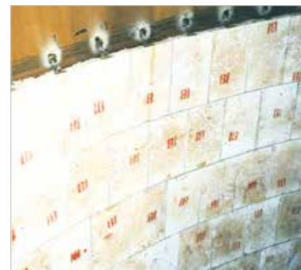
Protection contre l'usure à température élevée : cyclones de dépoussiérage de haut fourneau
