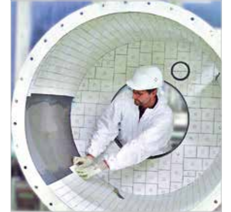
Revêtement en KALOCER d'une entrée de cyclone ; l'effet de voûte permet la mise en place de pièces de forme radiales avec le mortier de pose KALFIX, la paroi supérieure exige une fixation mécanique par coupelles à souder et bouchons d'étanchéité.
