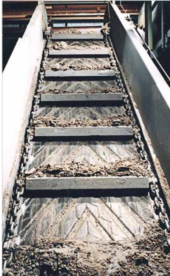
Convoyeur à chaîne à palettes pour l'évacuation des cendres humides dans une centrale thermique. Ces couloirs d'essorage dont le revêtement a été réalisé en fonderie limitent l'entraînement de l'eau dans la zone d'évacuation et abaissent ainsi sa consommation
