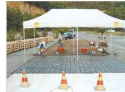
Le basalte fondu a fait ses preuves sur des pistes d'essai automobile dans le monde entier ; ici, la pose de « skid tiles » en Suisse
