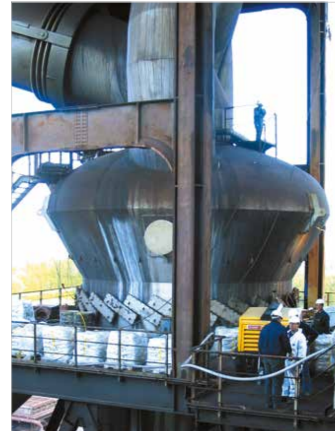
Revêtement de cyclone installé dans une aciérie, protégé avec le composite dur KALCRET à projeter
