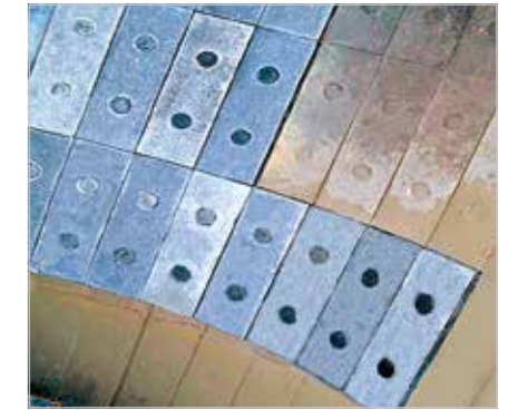
Blindage d'une conduite de charbon pulvérisé, réalisé en fonte
