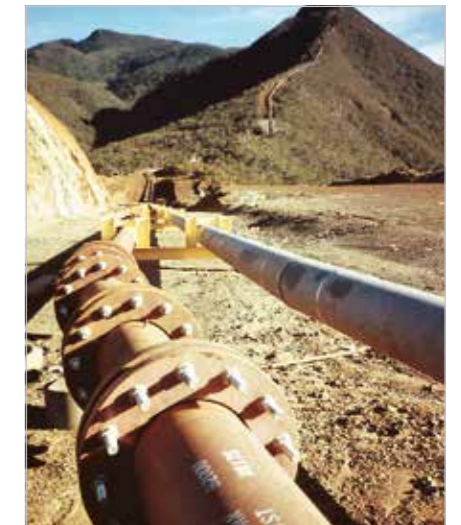
Tuyauteries garnies d'ABRESIST pour le transport hydraulique de minéral
