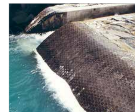
Déversoir d'eau protégé par l'ABRESIST
