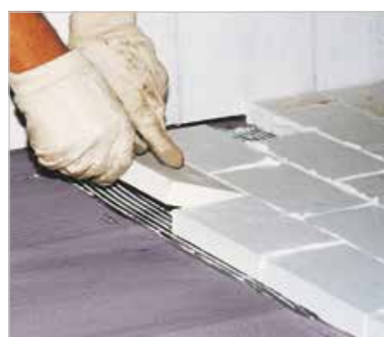
Pose et fixation avec mastics de résine synthétique
