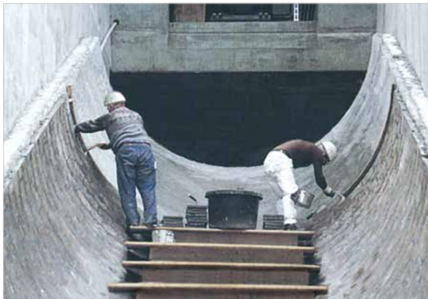
Dans les centrales de traitement d'eaux usées, on utilise souvent des dispositifs à vis sans fin pour l'élimination des déchets. Les couloirs de ces appareils doivent être protégés contre l'usure. Le basalte fondu ABRESIST convient parfaitement pour des diamètres maximum de 3 000 mm et des longueurs de 15 000 mm
