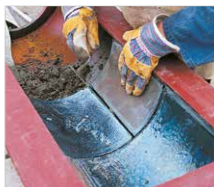
Pose avec mortier de ciment
