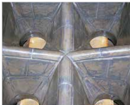
Des trémies d'évacuation de produits variés sont protégées par un revêtement anti-usure en ABRESIST
