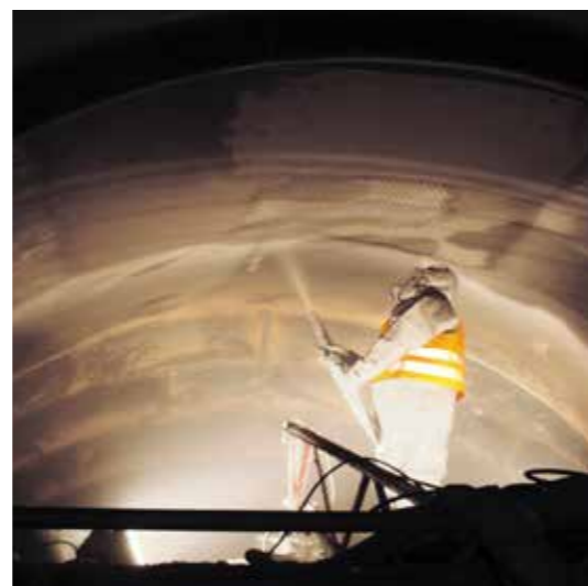
Protection des lignes de farine crue contre l'usure par abrasion avec le composé dur KALCRET, épaisseur du revêtement 25 - 40 mm, température d'utilisation 200 °C
