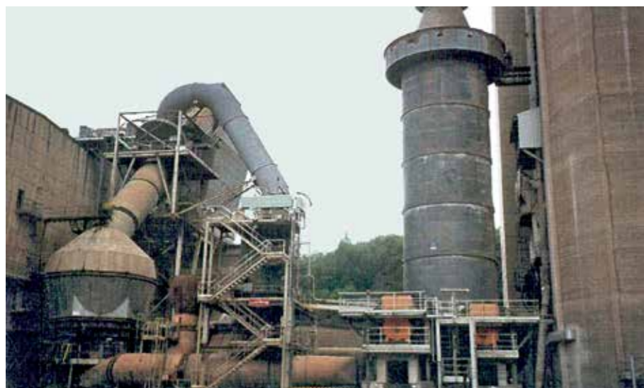
Protection efficace du broyeur à cru et du système de tuyauteries pneumatiques réalisée en composite dur KALCRET BNX
