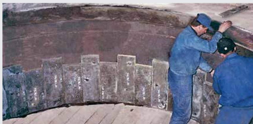
Protection des lignes de farine crue contre l'usure par abrasion avec le composé dur KALCRET, épaisseur du revêtement 25 - 40 mm, température d'utilisation 200 °C
