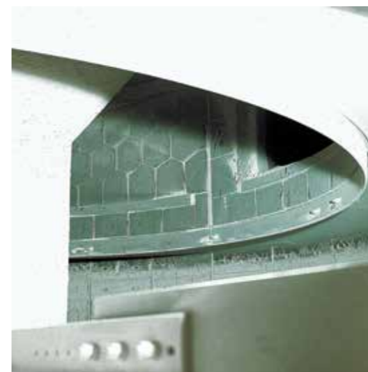
Le basalte fondu ABRESIST est un matériau de protection éprouvé pour séparateurs dans l'industrie du ciment.
